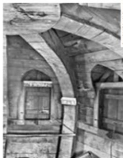
INTERIÉR KONSTRUKCE KALICHA
