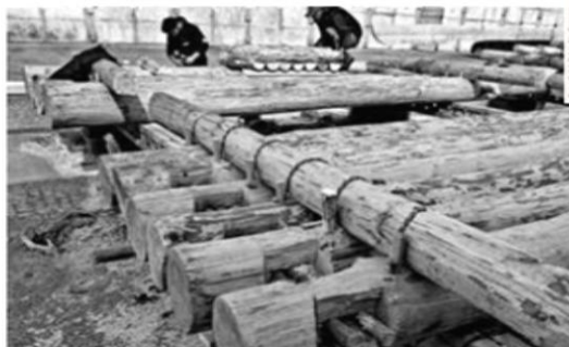
VĚŽA NI VORO PRO PLAVENÍ DŘEVA A VŠECHNY TESAŘSKÉ PRÁCE PŘEVÁDĚL ZKUŠENÝ TÝM POD VEDENÍM ZEDNĚNA ORAVCE.
